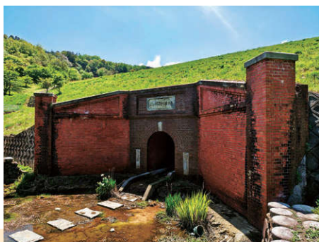
佳作「煉瓦造りの樋門」
