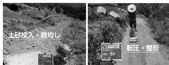
水食防止工 工事状況
