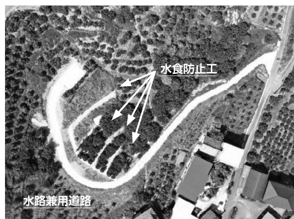
R6.9.5 上空から工事完成撮影
