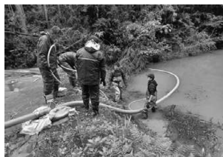
サイフォンによる水位低下作業
