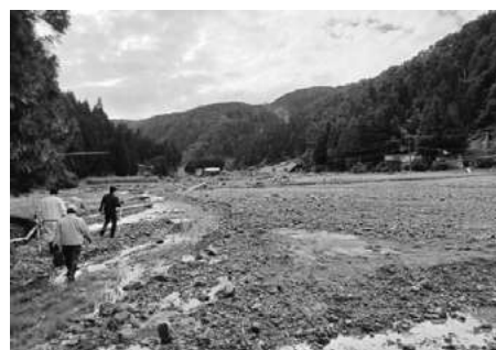
谷地形部の被災状況
