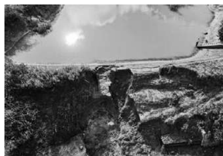
豪雨に伴う越水により決壊したため池
