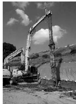
【地盤改良状況（下流側）】
