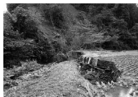
豪雨災害による被災状況
