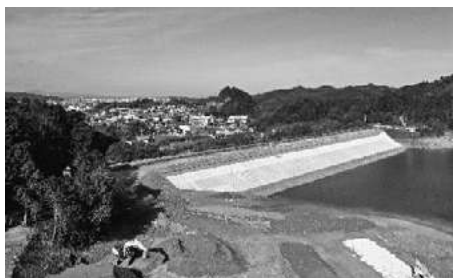
【上流側から撮影】
