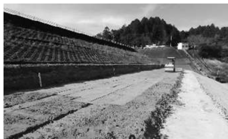
【改良盛土転圧状況（上流側）】
