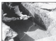
水路のひび割れ補修
