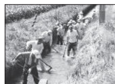
水路の泥上げ
