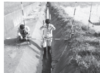
ポール横断での測量作業
