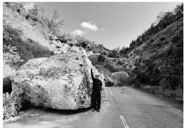
農道被災状況（写真中央：谷野）
