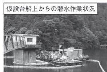
取水塔の改修は、上水を安定して供給するためダム水位を下げるできないため、潜水士による水中工事で実施した。工事期間中の上水の取水は、取水による潜水士の吸込み事故を防止するため、湖面上に設置した仮設フロート台船から、サイホンによる仮廻管水路にて、下流の調整水槽まで仮取水することとした。また、緊急事態に備え、事前に県・町・関係業者で「連絡協議会」を設立し、仮取水が停止した場合の緊急連絡体制や復旧対応等について念入りに協議、検討を行った。
