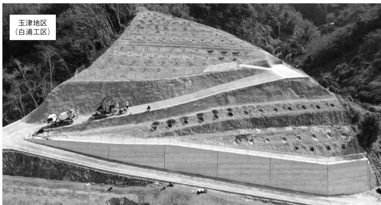
R6.2 工事の進捗状況
