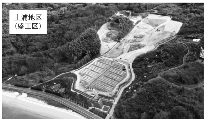
R6.2 工事の進捗状況
