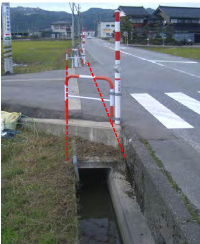
(農業用水路の道路占用箇所)
