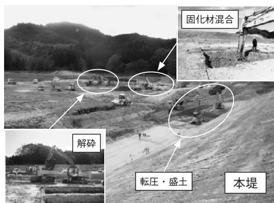
施工状況 (R5.1.25)
