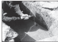
水路のひび割れ補修
