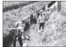
水路の泥上げ
