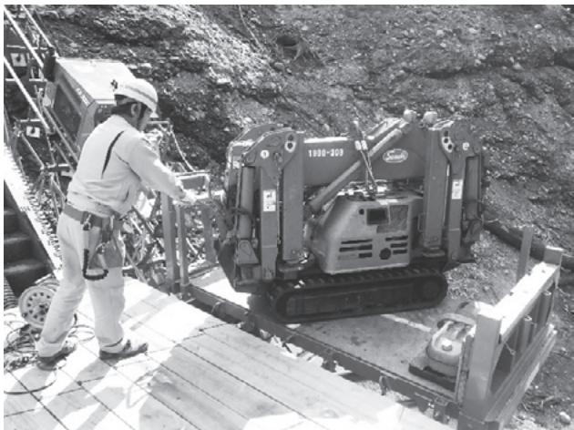
大型モノレールによりカニクレーンを搬入
