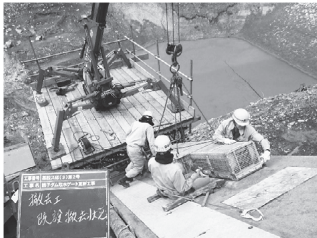
既存施設撤去状況
